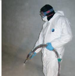
Адгезионное и гидроизоляционное покрытие на эпоксидно-цементной основе для влажного бетона и каменной кладки. Трехкомпонентный состав. Наносится минимум в два слоя. Светло-серый цвет. Используется как праймер для Masterseal M 336.
