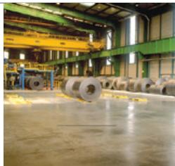
Сухая упрочняющая смесь на основе высокоактивного портландцемента, специально подобранных металлических заполнителей и добавок. Для упрочнения поверхности свежеуложенных (новых) бетонных полов внутри помещений, испытывающих высокие истирающие и высокие ударные нагрузки.
