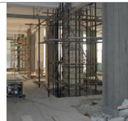
Однокомпонентная высокопрочная армированная фиброй безусадочная смесь наливного типа с повышенным модулем упругости, разработанная на основе нанотехнологии. Толщина слоя от 20 до 200 мм
