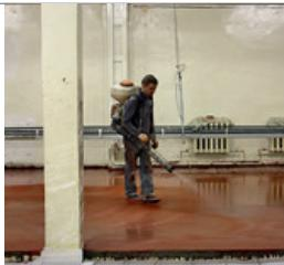
Запечатывающий материал для последующего ухода за бетоном, в том числе цветным. Образует на поверхности бетона мембрану, которая запечатывает поры и препятствует интенсивному испарению воды из бетона, что обеспечивает гидратацию цемента в оптимальных условиях.
