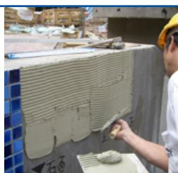
Универсальный высокоэластичный плиточный клей для укладки всех видов плитки на нестабильные основания\*
