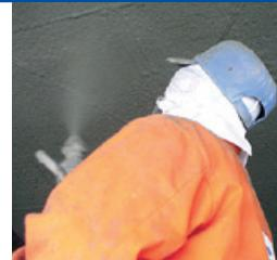
Безусадочная сверхбыстротвердеющая сухая смесь тиксотропного типа для конструкционного ремонта бетона и железобетона в сжатые сроки. Для работ при температуре до -10°C. Толщина нанесения от 10 до 100 мм.
