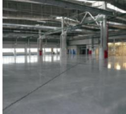
Сухая упрочняющая смесь на основе высокоактивного портландцемента, специально подобранных корундовых заполнителей, полимерной фибры и добавок. Для упрочнения поверхности свежеуложенных (новых) бетонных полов по «литой» технологии, а также для устройства тонкослойного высокопрочного покрытия существующих (старых) бетонных полов внутри и снаружи помещений, испытывающих высокие истирающие и умеренные ударные нагрузки. Толщина покрытия по существующему бетонному основанию от 5 до 15 мм.
