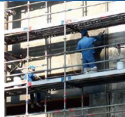
Полимермодифицированная мелкозернистая сухая смесь тиксотропного типа с пониженной плотностью, разработанная на основе нанотехнологии. Толщина нанесения от 5 до 75 мм
