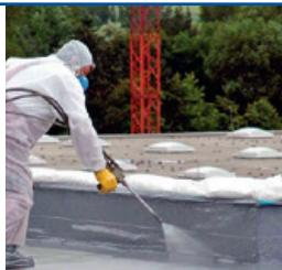
Система предназначена для гидроизоляции всех типов плоских или покатых кровель. Для кровли с уже существующими покрытиями, например, инвертированные кровли, кровельные сады и ландшафтные территории.
