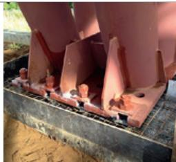
Безусадочная быстротвердеющая сухая смесь наливного типа. Для высокоточной цементации (подливки) оборудования, металлоконструкций, омоноличивания стыков в конструкциях и установки анкеров. Максимальная крупность заполнителя составляет 2,5 мм. Толщина заливки от 20 до 200 мм и более.
