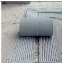
Система гидроизоляции всех типов швов и трещин при строительстве и ремонте, подверженных прямому давлению воды до 8 атм. Представляет собой ленту на основе термопластичного эластомера, наклеиваемую на эпоксидный состав MasterSeal 933 (также возможно применение эпоксидной шпатлевки серии MasterBrace ADH). Соединение лент посредством сварки.
