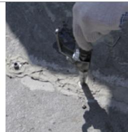
Двухкомпонентная низковязкая эпоксидная инъекционная смола для ремонта сухих и влажных трещин раскрытием от 0,2 до 5,0 мм в бетонных конструкциях и каменной кладке. Для однокомпонентного инъекционного насоса
