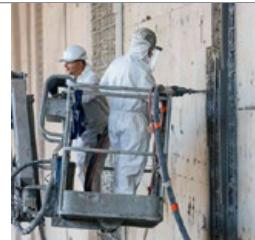
Высокопрочная безусадочная сухая смесь тиксотропного типа с полимерной фиброй, разработанная на основе нанотехнологии. Толщина нанесения от 5 до 50 мм
