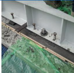
Высокопрочный 3-х компонентный состав на эпоксидной основе для высокоточного монтажа. Толщина укладки от 12 до 150 мм.
