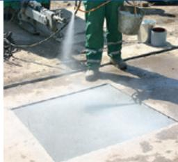
Материал для уменьшения испарения воды с поверхности бетона в пластичном состоянии. Обеспечивает качественное выполнение бетонных работ в сложных условиях: высокая температура и/или низкая влажность воздуха, наличие сквозняков, воздействие прямых солнечных лучей и т.д.
