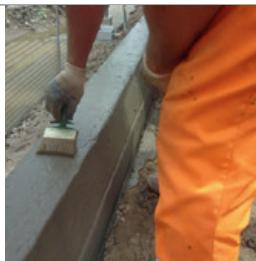
Средство для защиты свежеуложенного бетона от слишком быстрого испарения воды.
