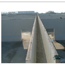
Однокомпонентное эластичное полимерцементное покрытие для защиты бетона и гидроизоляции конструкций. Не нужен жидкий полимер для затворения! Сверхнизкий расход. Экономия при транспортировке, хранении и нанесении. Наносится в два слоя общей толщиной от 2 мм. Светло-серый и белый цвет.
