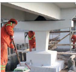
Эластичное гидроизоляционное полимерцементное покрытие, пригодное для контакта с питьевой водой.
