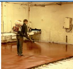
Запечатывающий материал для последующего ухода за бетоном натурального цвета. Образует на поверхности бетона мембрану, которая запечатывает поры и препятствует интенсивному испарению воды из бетона, что обеспечивает гидратацию цемента в оптимальных условиях.
