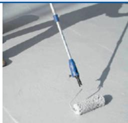
Система предназначена для гидроизоляции всех типов плоских или покатых кровель. Применяется при устройстве «зеленых кровель» без нанесения защитного слоя.
