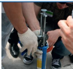
Универсальный двухкомпонентный тиксотропный состав для крепления анкеров на метакрилатной основе, не содержащий стирола. Предназначен для крепления анкеров подверженных средним и высоким нагрузкам в пустотелых блоках или плотном камне.
