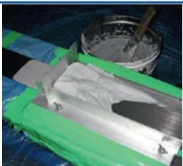
Высокопрочный эпоксидный клей для стержней и ламелей системы MasterBrace.
