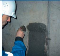
Однокомпонентный состав проникающего действия на цементной основе для уплотнения структуры бетона.
