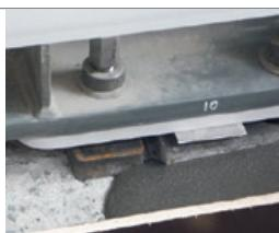
Высокопрочный состав с металлическим заполнителем для высокоточной цементации оборудования подверженного высоким ударным и динамическим нагрузкам. Толщина применения от 20 до 150 мм.
