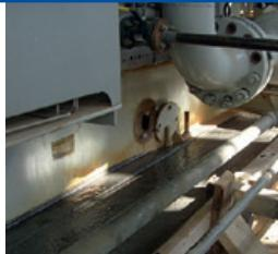
Безусадочная быстротвердеющая сухая бетонная смесь наливного типа. Для высокоточной цементации (подливки) оборудования, металлоконструкций, омоноличивания стыков в конструкциях и установки анкеров. Максимальная крупность заполнителя составляет 10 мм. Толщина заливки от 40 до 100 мм.
