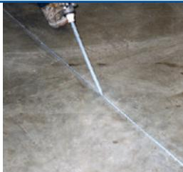
Однокомпонентный эластичный полиуретановый влагостойкий герметик для швов шириной от 5 до 30 мм, в том числе, подвергающихся постоянному воздействию воды
