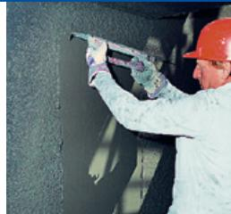
Жесткое покрытие на цементной основе для защиты бетонных конструкций от воздействия канализационных вод.
