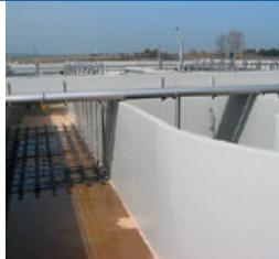
Эластичное покрытие на эпоксидно-полиуретановой основе для защиты и гидроизоляции бетона, без растворителей. Двухкомпонентный состав. Наносится в два слоя. Серый цвет Ral 7032. Наносится с праймером MasterSeal P 385
