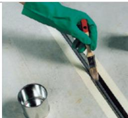
Однокомпонентная полиуретановая адгезионная грунтовка для подготовки стенок швов при их герметизации. Для улучшения адгезии полиуретановых и силиконовых герметиков MasterSeal на бетонных, кирпичных и каменных основаниях.
