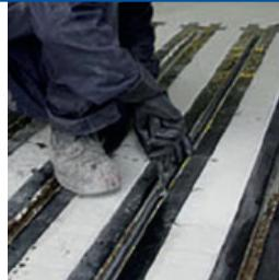
Композитные стержни на основе однонаправленных углеродных волокон (максимальная длина 12 м).
