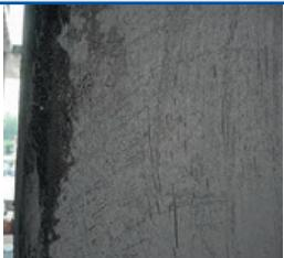
Тиксотропная шпатлёвка на основе 2-х компонентной эпоксидной смолы, используемая в системе MasterBrace для выравнивания поверхности, а также в качестве ремонтной и анкеровочной смеси.
