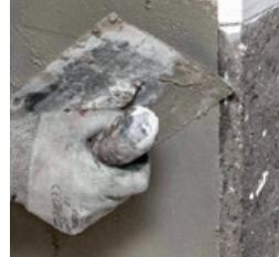
Быстроотвердевающая выравнивающая смесь с полимерной фиброй, разработанная на основе нанотехнологии. Для выравнивания бетонной поверхности и ее финишной отделки. Толщина слоя от 0,5 до 7 мм.
