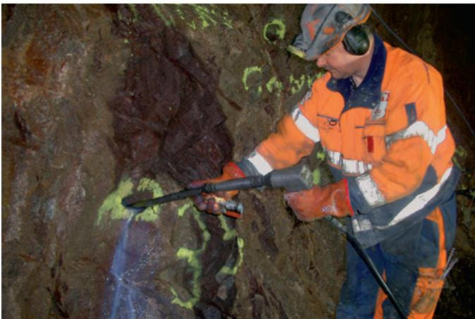
Эластичный ремонт гидроизоляционных систем тоннельных обделок и шахтной крепи
