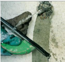
Быстрохватывающийся состав на цементной основе для заделки активных протечек воды в бетоне и кирпичной кладке.
