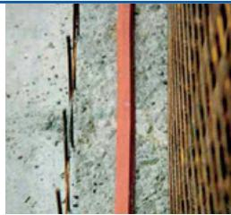
Гидроизоляционный шнур на акрилатной основе, расширяющийся при контакте с водой. Предназначен для гидроизоляции конструкционных швов (исключая деформационные), подверженных нагрузке напорной воды. Устанавливается только на расширяющийся клей MasterSeal 912.
